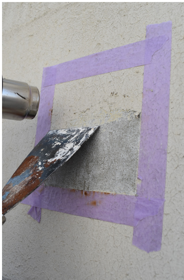
Decapering met warme lucht op de cementpleister
